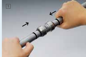
パイプ差し込み
